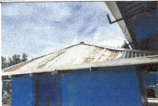
Foto 1: Sustrucción de lámina, por lámina troquelada aluzinc calibre 26
