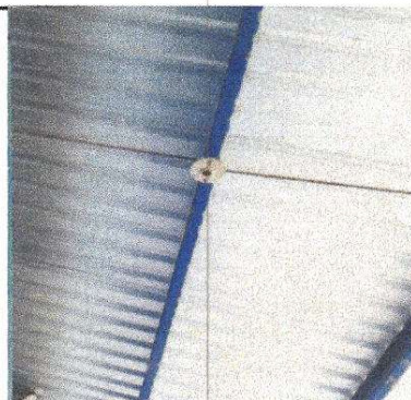
Foto 10: Sustitución de focos ahorradores
