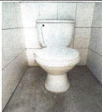
Foto 7: Sustitución de inodoro
