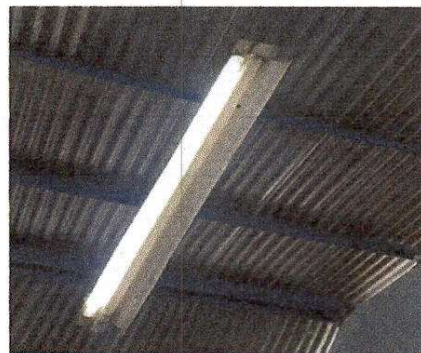
Foto 8: Sustitución de lamparas de 2 x 40
