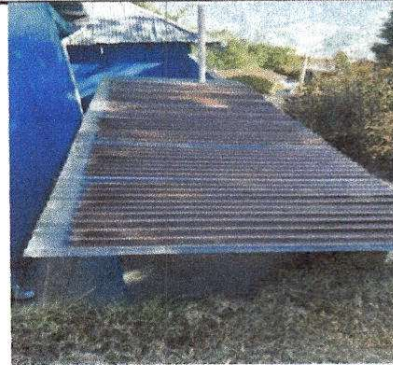
Foto 2: Sustrucción de lámina, por lámina troquelada aluzinc calibre 26
