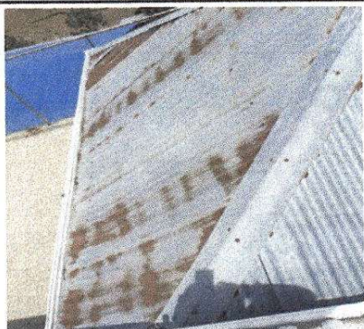
Foto 3: Sustrucción de capote de lámina para lámina troquelada
