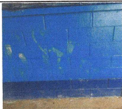
Foto 5: Pintura en muros exteriores e interiores
