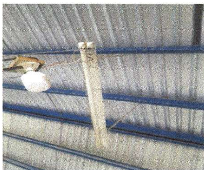
Foto 9: Sustitución de lamparas de 2 x 40
