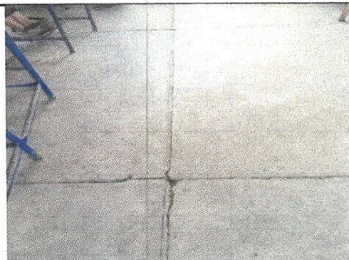
Foto 4: Sustrucción de piso cerámico
